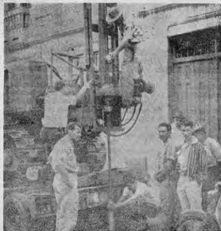
El Ministerio de Obras Públicas ha estado realizando pruebas de terrenos en varias calles de la ciudad de San José, con el fin de que se empleen, a la hora de reconstruirla, los materiales y sistemas adecuados en cada caso. Vemos en la gráfica la máquina perforadora en acción.
